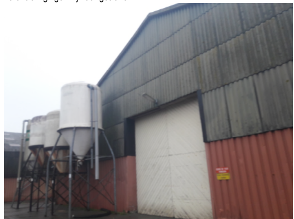
Fotonummer: 6 Omschrijving: Voorzijde loods (zie ook fotonummer 2) en silo's en recentere loodsen op de achtergrond
