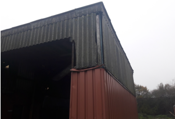
Fotonummer: 3 Omschrijving: Detail loods van fotonummer 2
