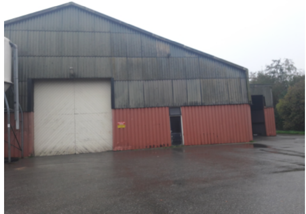
Fotonummer: 2 Omschrijving: Voorzijde loods, rechterzijde van Terheijlsterweg 53
