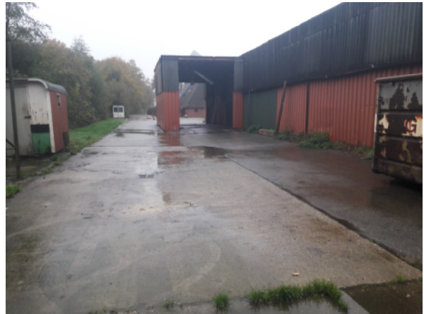
Fotonummer: 4 Omschrijving: Zijkant loods van fotonummer 2 met wasplaats. De foto geeft de locatie weer waar in onderzoeken in 2011-2012 plaatselijke verontreinigingen zijn aangetroffen
