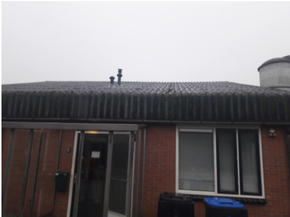
Fotonummer: 7 Omschrijving: Kantooraanbouw bij loods
