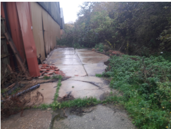
Fotonummer: 5 Omschrijving: Achterzijde loodsen (links) en grondwal (rechts)
