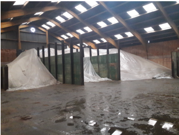
Fotonummer: 15 Omschrijving: Opslag kunstmest in loodsen. De dakbedekking bestaat uit golfplaten
