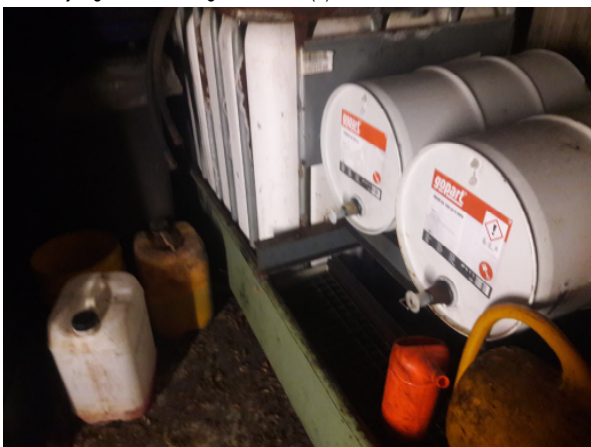
Fotonummer: 11 Omschrijving: Opslag bij bovengrondse tank
