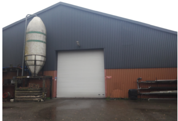
Fotonummer: 12 Omschrijving: Voorzijde recent gebouwde loods en silo
