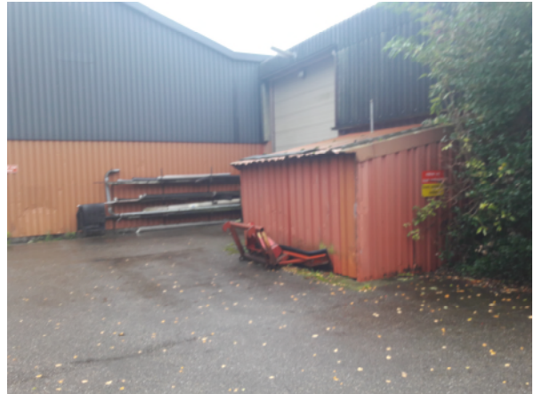
Fotonummer: 8 Omschrijving: Locatie van bovengrondse tank (rode schuurtje)
